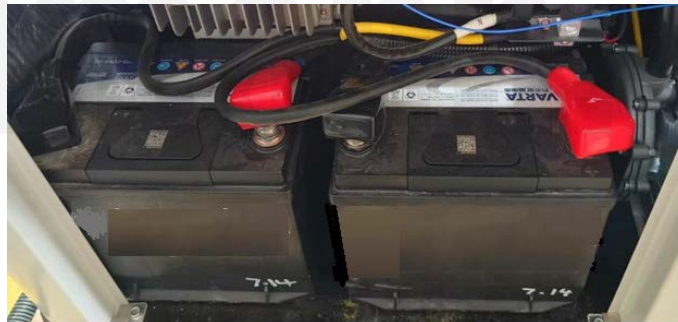
Fig. 6-2: Conecte el cable de la batería
